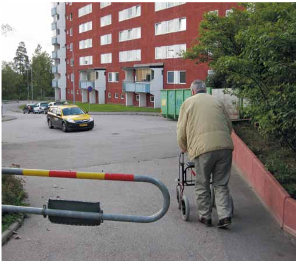
Bommarna in till gården hindrar färdtjänsten från att komma fram till entrén, därför måste de äldre gå till gatan för att möta färdtjänsten.
